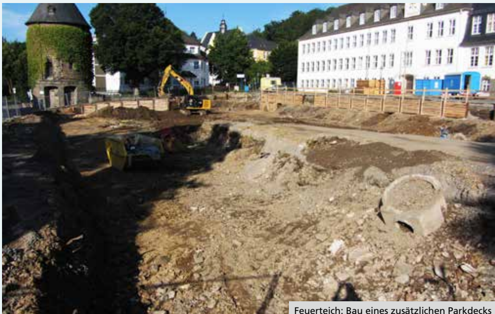
Feuerteich: Bau eines zusätzlichen Parkdecks
