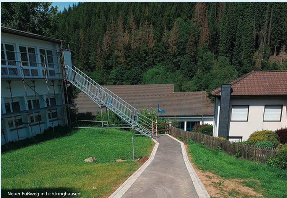
Neuer Fußweg in Lichtringhausen
