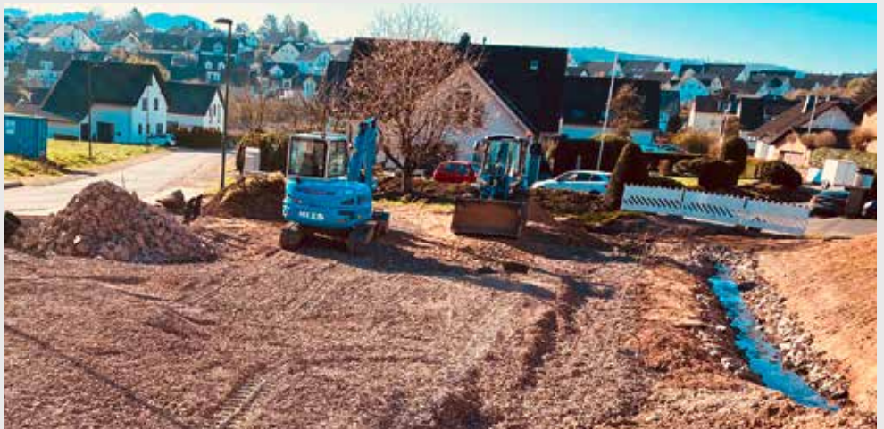
Bau des Dorfplatzes in Biekhofen
