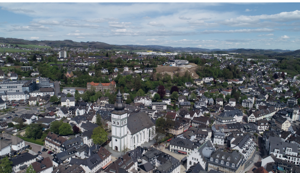
Blick auf die Innenstadt und die damalige Baustelle des Bürgerparks im Hintergrund. Nezahat Baradari setzte sich erfolgreich für eine Förderung des Parks mit Bundesmitteln ein.
