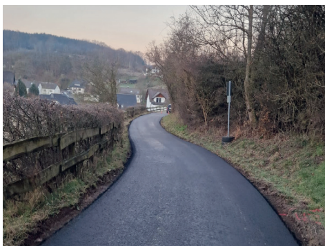
Der Förder Weg mit der neuen Asphaltdecke
